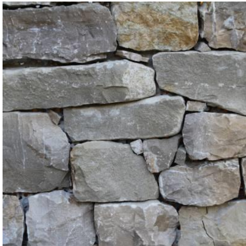
Figura 1. Esempio di rivestimento in pietra a spacco a fuga aperta (tipo a secco)
