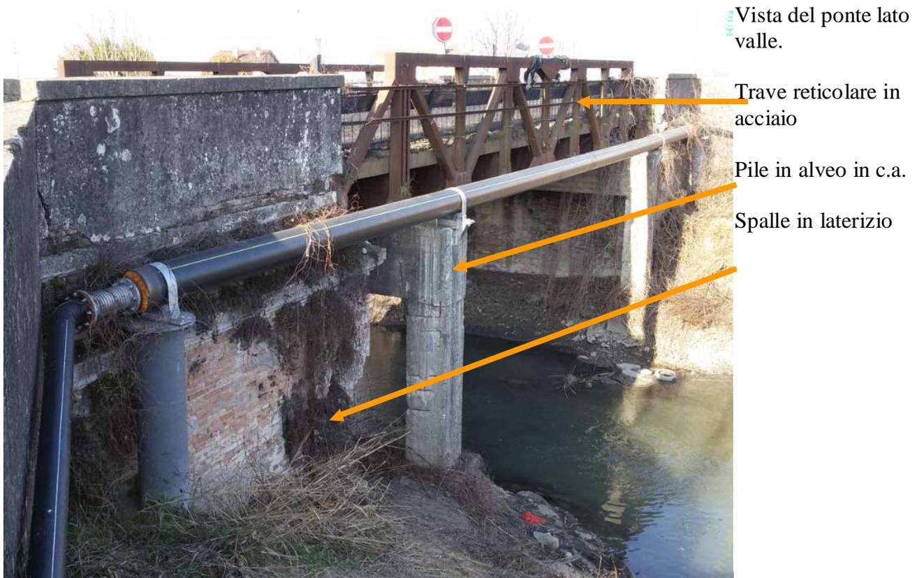
L'opera in oggetto è un ponte piuttosto singolare: è un manufatto misto con spalle in laterizio, due pile in alveo in c.a. a distanza di soli 2,50 m dalle spalle ed una luce centrale netta di circa 12 m.
