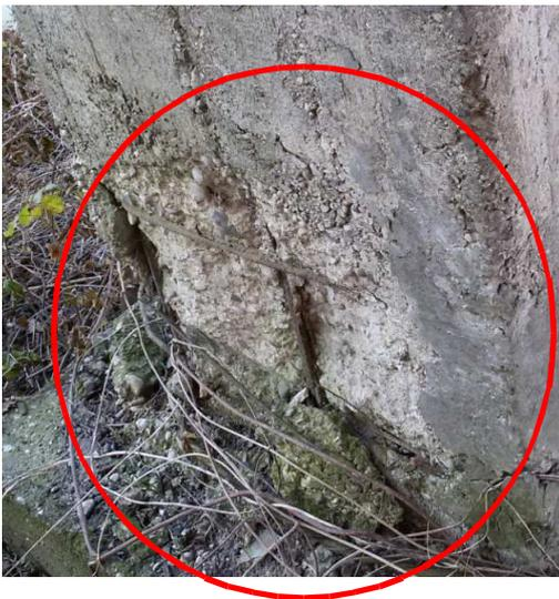
particolare base pila di monte in destra, probabile espulsione cls per ferri disallineati all'attacco plinto.
