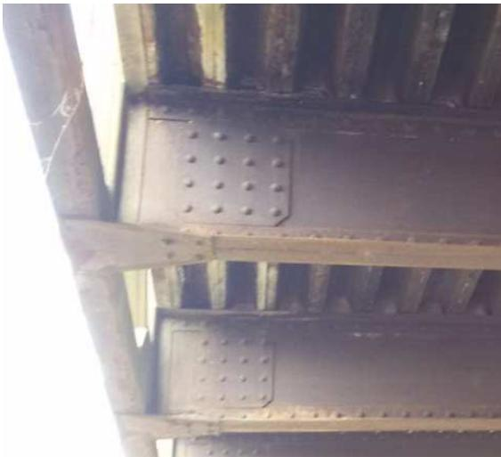
Particolare dei nodi di giunzione chiodati dei traversi e dei fazzoletti di giunzione dei profili pure chiodati.
