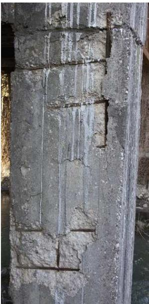
particolare pila di valle in destra, espulsione copriferro, armature arrugginite.
