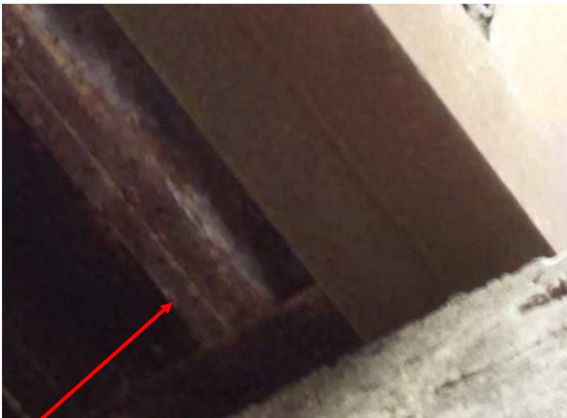
Particolare del corrente inferiore della trave parete reticolare principale lato valle in corrispondenza dell'appoggio sulla pila in c.a. (appoggio diretto senza alcuna interposizione) e dell'intradosso della soletta, realizzato con cassaforma metallica con elementi metallici a U rovesci accostati con probabile getto integrativo in cls (armato?). Il corrente a sezione tubolare è realizzato con profilati aperti saldati. E ciò porta la realizzazione della trave a dopo il 1901.
