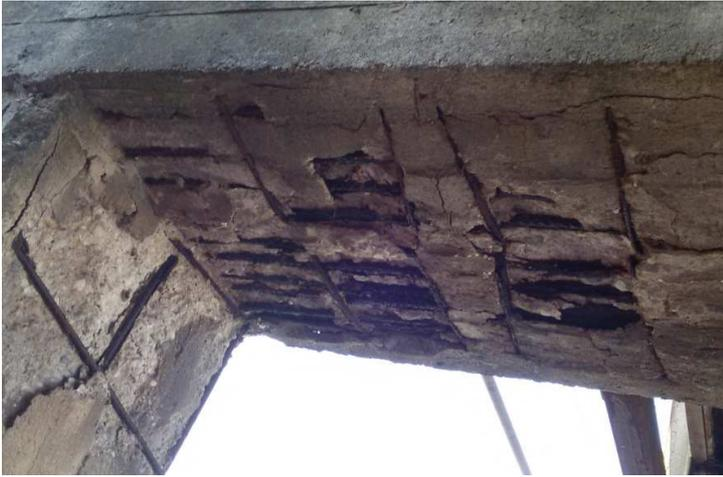
Particolare pulvino in destra, lato monte, parte inferiore: espulsione copriferro, armature arrugginite.
